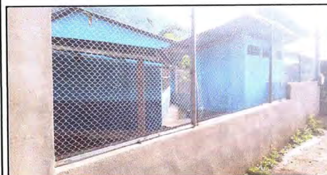
Foto 5: Muro perimetral remodelado y reforzado.
