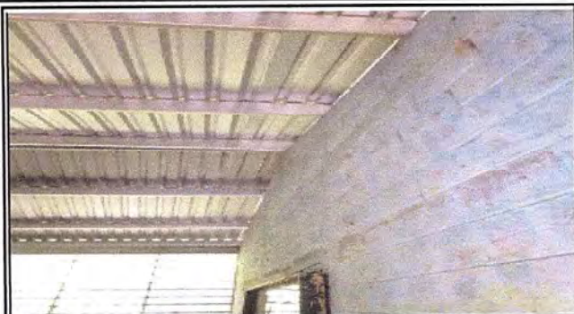
Foto 1: Instalación de lámina y estructura metálica calibre 26.
