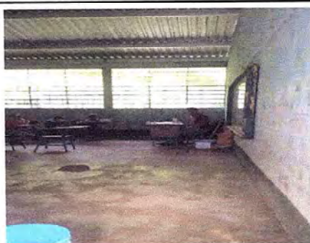
Foto 2: Cambio en techos en las aulas para evitar el flujo de agua.
