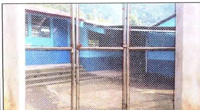
Foto 3: Reparación del porton.
